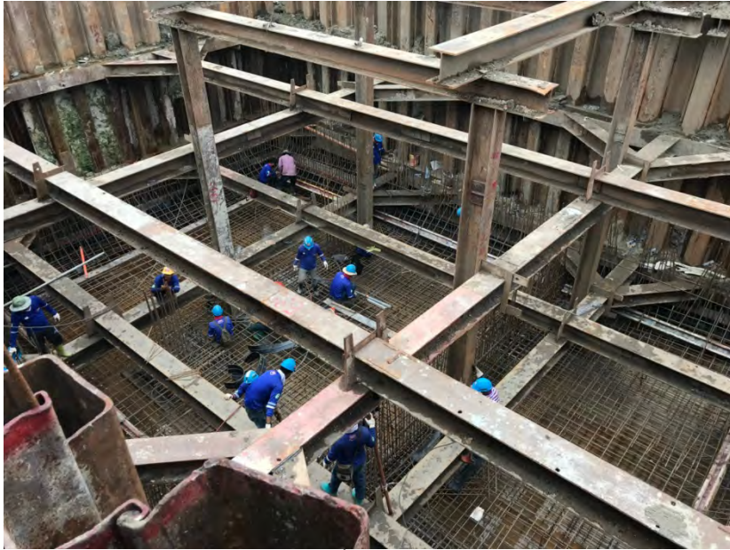
รูป ก่อสร้างชั้น surge Tank
