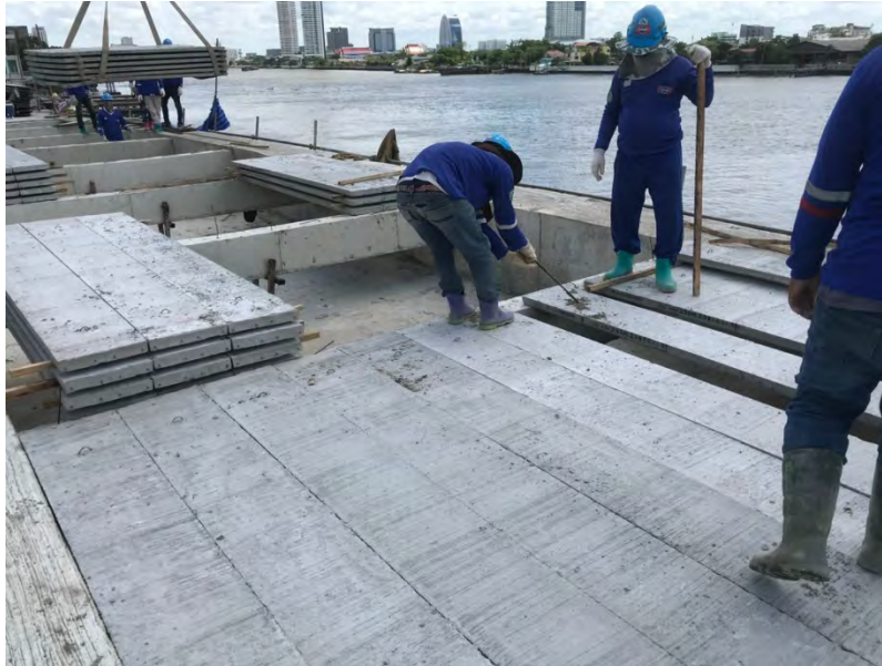
รูป วางแผ่น Pank (พื้นหลังคา)
