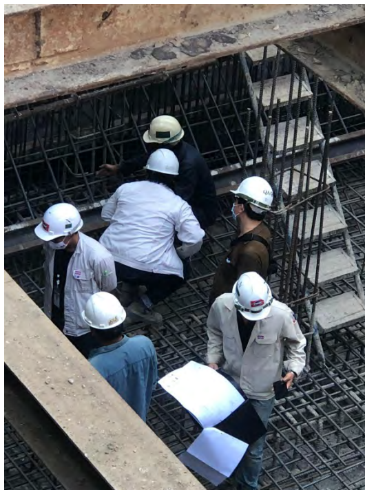
รูป การตรวจก่อสร้าง Surge Tank
