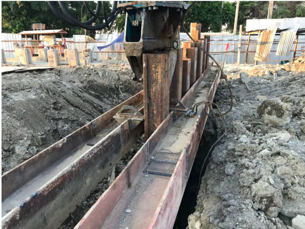
รูป เริ่มปักSheet pile เพื่อก่อสร้างSoil Protection
