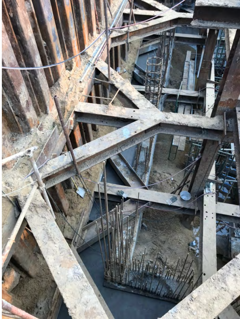
4. รูป Back Fill ทรายและเทพ้องLean ก่อนหรือBracing
