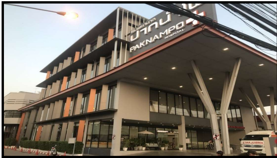
ควบคุมงาน Renovate โรงพยาบาลปากน้ำโพ 1 จังหวัดนครสวรรค์
