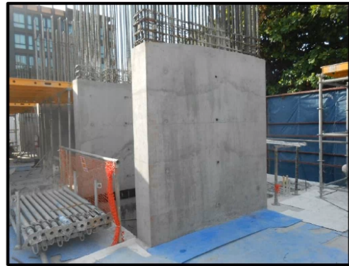
รูปที่ 1 งานค้ำยันและตั้งไม้แบบผนังปล่องลิฟต์
