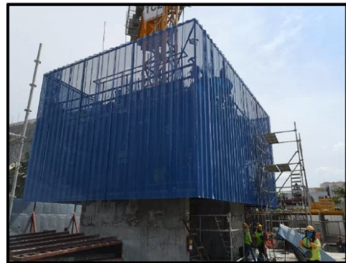
รูปที่ 2, 3, 4 งานหล่อไม้แบบของเสาและผนังลิฟต์
