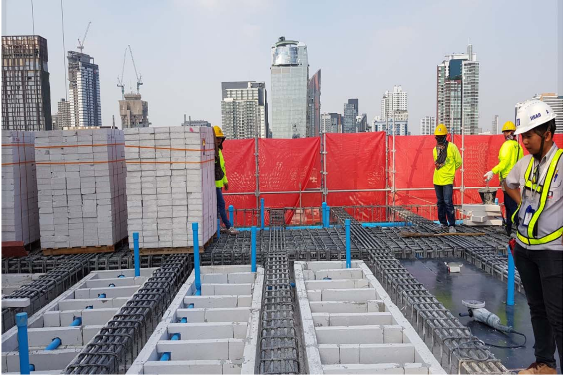
รูปที่ 5 งานเตรียมผูกเหล็กและฝังท่อพื้นคานถ่ายแรงทางเดียว
