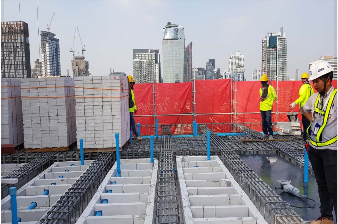
รูปที่ 3 งานเตรียมผูกเหล็กและฝังท่อพื้นคานถ่ายแรงทางเดียว
