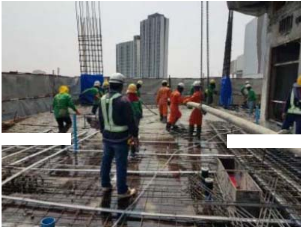
รูปที่ 9 งานเทคอนกรีตพื้นชั้น 8
