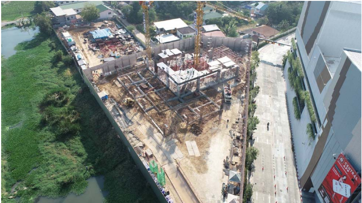
รูปที่ 6 งาน โครงสร้างภาพมุมสูงที่ 1
