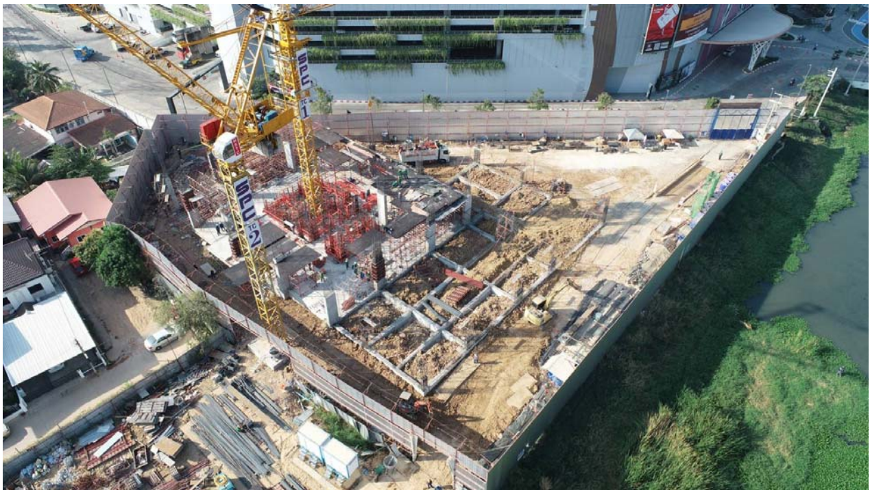
รูปที่ 7 งาน โครงสร้างภาพมุมสูงที่ 2
