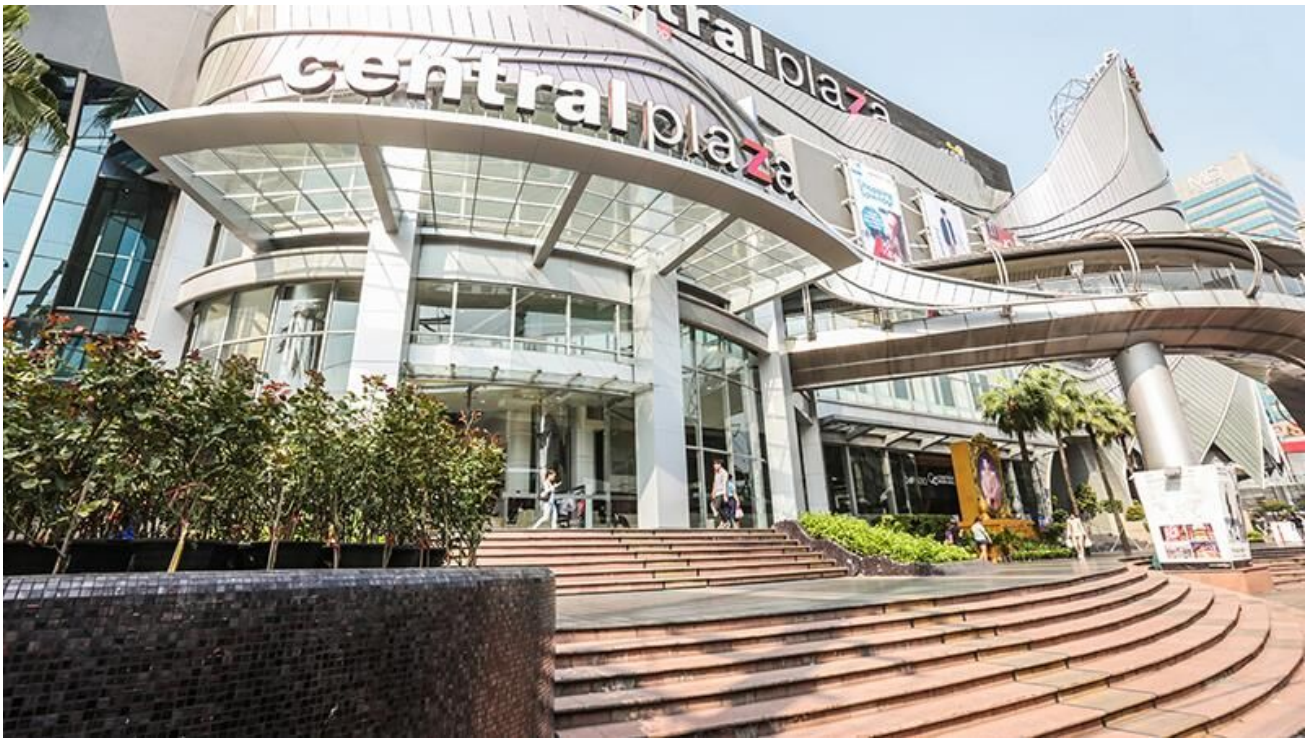
CentralPlaza Bangna “งานปรับปรุงสถาปัตยกรรม และตกแต่งภายนอก (Package 2)”
