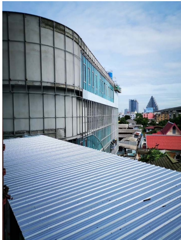
ภาพที่ 6 : หลังคาทางเดินเชื่อมระหว่างอาคาร A และอาคาร B
