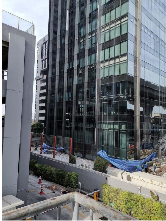
ภาพที่ 1 : สำนักงานใหญ่ บมจ. กรุงเทพประกันชีวิต ขณะก่อสร้าง
