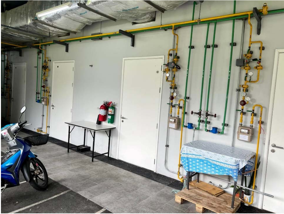
ภาพที่ 15 : บริเวณหลังร้านค้า ร้านอาหาร
